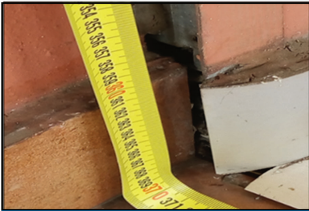
Fig.4 Deslocamento vertical na ligação da parede e Laje de pavimento (Fonte: Autor)
